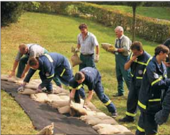
Deichfußsicherung: Teamarbeit der Mitarbeiter des Wasserversorgungsamtes Ansbach und der THW-Helfer des GFB Nürnberg
