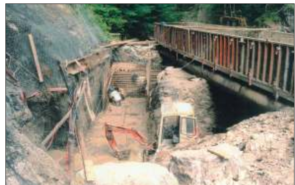
Bild 2: Ausbau der unbrauchbar gewordenen Armierung
