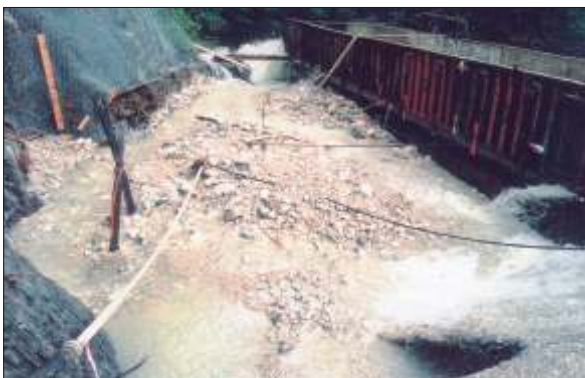
Bild 1: Mit Geschiebe verfülltes Fundament die Flussmeister 2004
