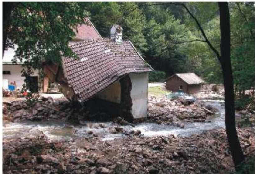
Bild 10: Nur noch Reste blieben von diesem Haus übrig
