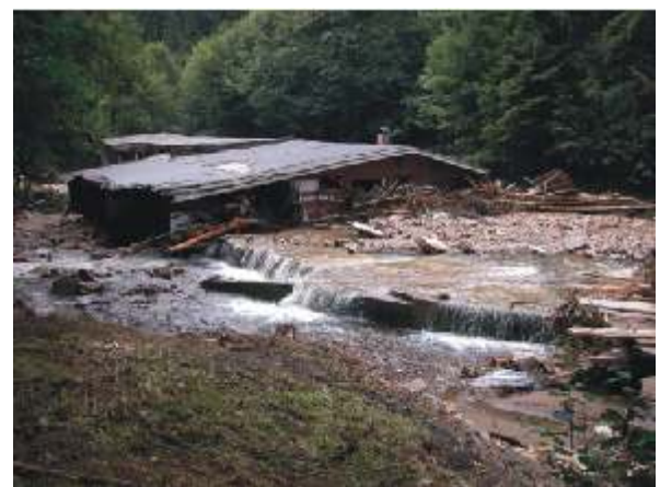
Bild 6: Das Gebäude wurde nach dem Hochwasser abgerissen
