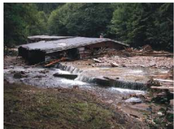
Bild 6: Das Gebäude wurde nach dem Hochwasser abgerissen
