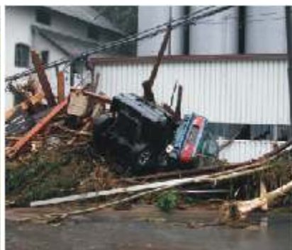
Bild 2: Unüberschaubares Schadensmaß nach dem Hochwasserereignis
