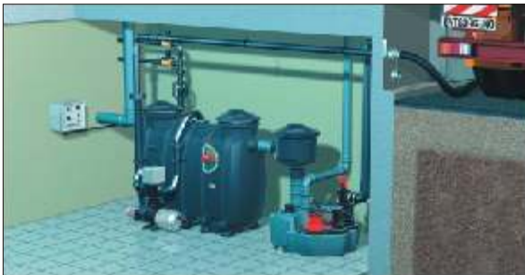
Bild 4: EN-Fettabscheideranlage mit Entleer- und Spüleinrichtung
