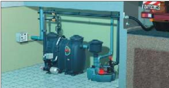
Bild 4: EN-Fettabscheideranlage mit Entleer- und Spüleinrichtung
