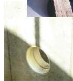
Links Foto 3: Vorgeschriebener Schachtanschluss Rechts Foto 4: Sammelschacht für Silagesickerwässer
