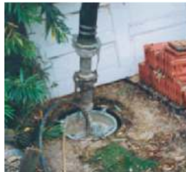
Foto 14: Vakuumprüfung einer Sammelgrube für Silagesickersäfte
