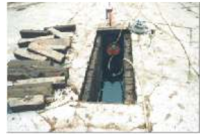
Foto: 9 und 10 Absperrung der Grubenzuläufe
