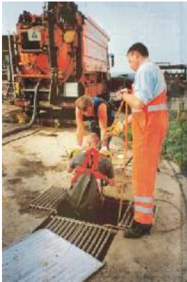
Foto 6: Behälterbesichtigung durch Fachfirma (Seilsicherung nicht fachmännisch)
