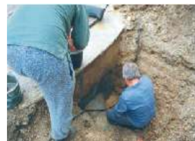
Foto 5: Undichter Rohranschluss (in Öffnung gesteckt und hinterfüllt) wird nachträglich abgedichtet
