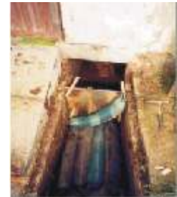
Foto: 9 und 10 Absperrung der Grubenzuläufe
