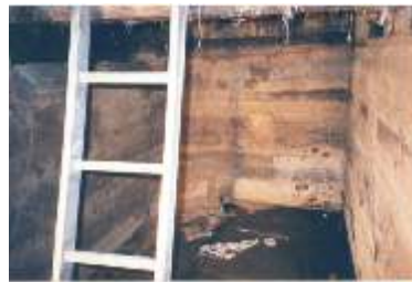
Foto 7: Verbindungsleitung auf Höhe der Grubensohle
