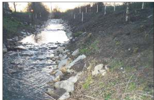
Bild 2: Die Raue Rampe unmittelbar nach der Fertigstellung
