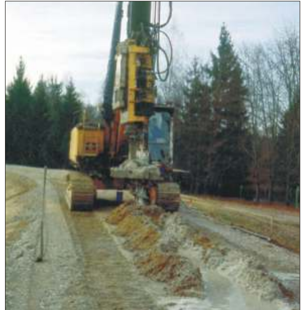
Bild 6 :Mit einem Spezialbagger wird die Deichdichtung eingebracht
