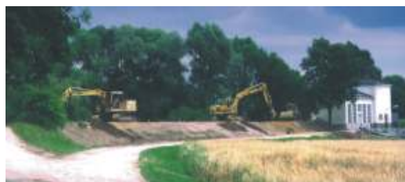
Bild 2: Beseitigung der Schäden am Polderdamm im Bereich des Schöpfwerkes Neustadt 1999
