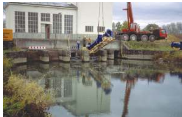
Bild 3: Einbau der Saugleitungen mit einem Autokram
