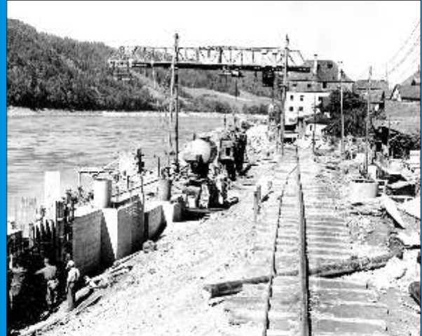
Abb. 28: Dichtungswand im Bau 1954 (Bauzeit 1952-1954)
