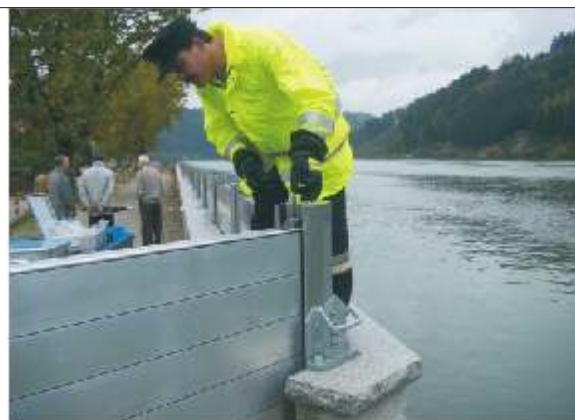
Abb. 5: Schnitt durch das Hochwasserschutzsystem und Probeaufbau des mobilen Hochwasserschutzes
