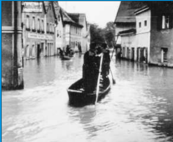
Abb. 27: Überflutete Ortsdurchfahrt (Bundesstraße B 388) 1954
