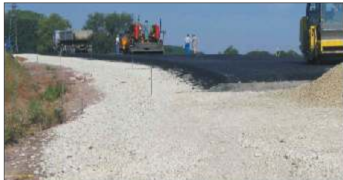
Abb. 6: Bau der Staatsstraße
