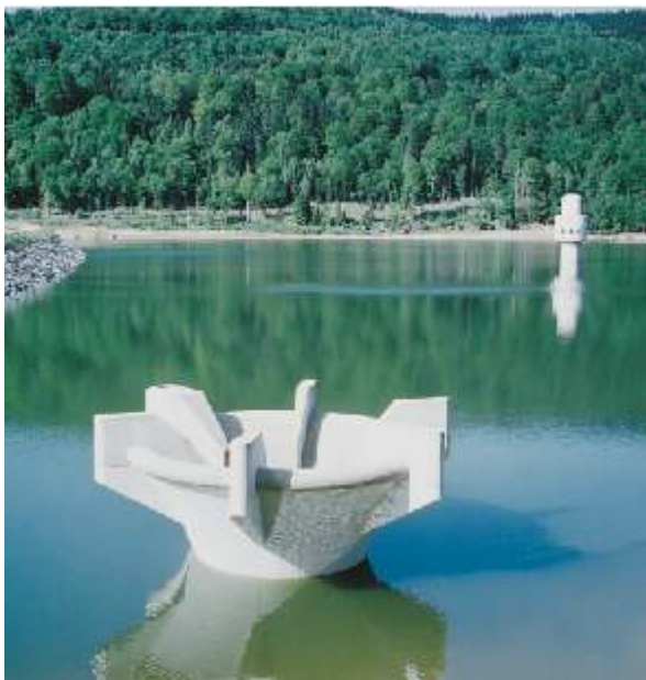
Bild 4: Entnahmeturm und Einlaufbauwerk der Hochwasserentlastung (im Vordergrund)
