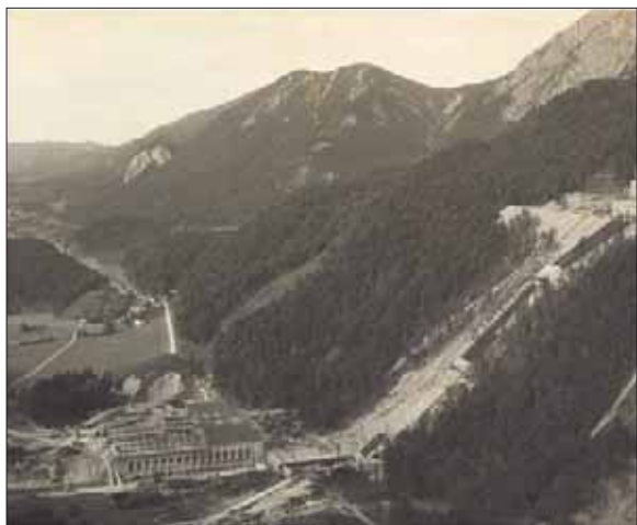
Abb. 1: Das Walchenseekraftwerk während der Bauzeit
