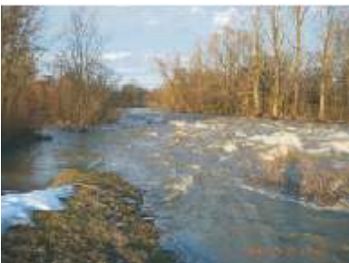
Abb. 3: Wellenbild unterhalb der Rampe
