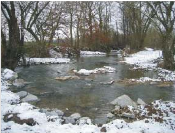
Abb. 4: Uferabflachung und Sohlanhebung durch Rampen, Bühnen und Kieseinbringung
