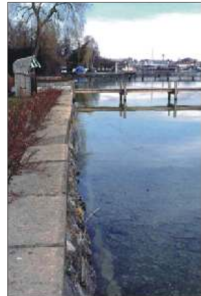
Abb. 4: Ufermauer in Starnberg vor der Renaturierung (Bild: Wasserwirtschaftsamt München)
