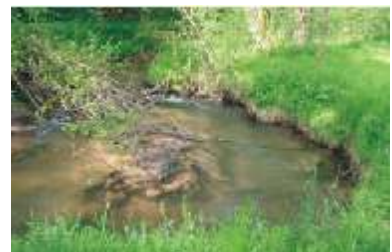
Bilder 3-7: Die Bilder zeigen den Verbau des Uferanbruches und die Entwicklung im Laufe eines drei viertel Jahres
