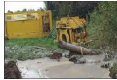
Bild 5: Austritt des Bohrkopfs am Ziel einer Pilotbohrung
