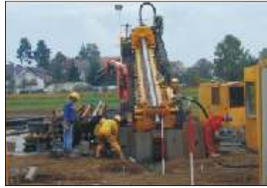
Bild 4: Große HDD - Bohranlage
