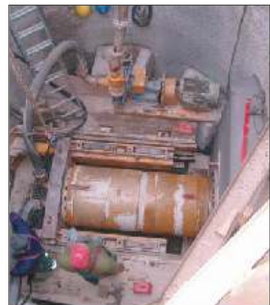
Bild 7 Blick in eine Anfahrgrube Rohrvortrieb mit dem Schild
