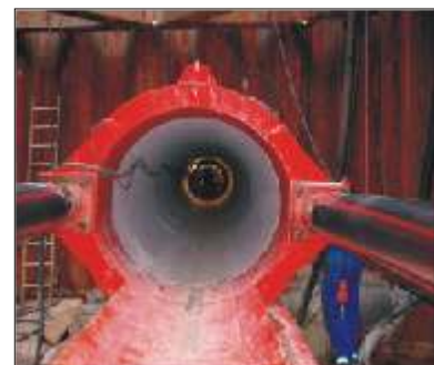
Bild 8 Vortriebspressen Rohrvortrieb
