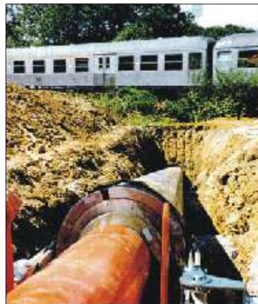
Bild 6 Vortrieb im Rammverfahren
