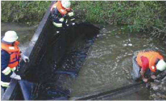
Abb. 2: Einbau einer starren Tauchwandsperre
