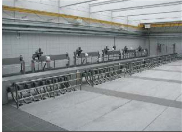
Bild 5: Aufnahme nach der Fertigstellung
