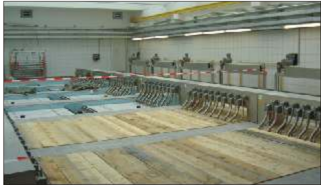
Bild 4: Aufnahme während der Einbauphase
