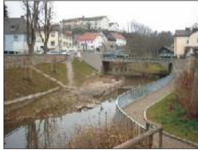
Abb. 2: Hochwasserschutzmaßnahme Bogenbach (WWA - Deggendorf, Nov. 2003)
