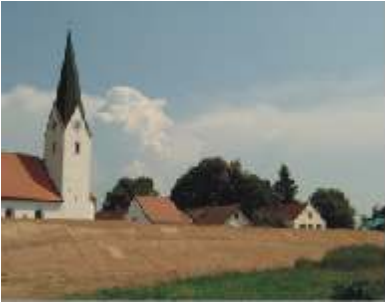
Abb. 1: Donaudeichsanierung in Maria-pösching (WWA - Deggendorf, April 2003)
