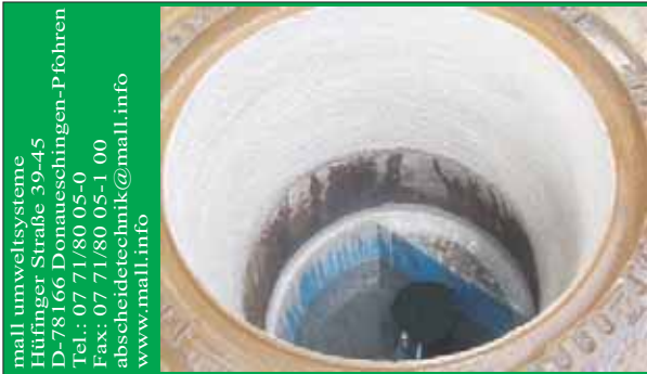
Abb. 2: Gerettet: Die schnelle und fachgerechte Sanierung bereits im Zuge der Inspektion ist möglich, wenn ein erfahrener Hersteller die Abscheider-Prüfung von vorne herein begleitet. Nach vergleichsweise kurzer Betriebsunterbrechung darf die Anlage wieder ihren Dienst aufnehmen. Bild: Mall
