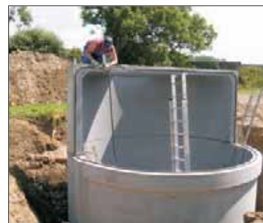
Abb. 2: Die verschiedenen Behälter der Kläranlage -hier der Zulaufpuffer- wurden aus Stahlbetonfertigteilen in monolithischer Bauweise errichtet. Bild: Mall
