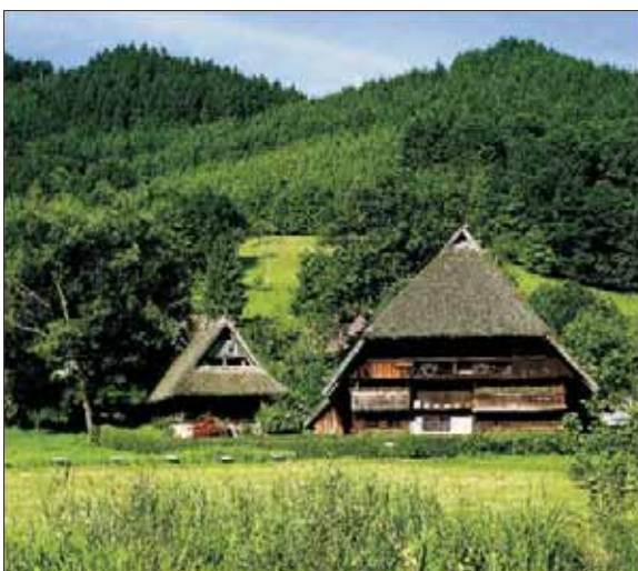
Abb.:1 Alleinlage im Wasserschutzgebiet. Bayern hält für Käufer von Kleinkläranlagen ein vereinfachtes Genehmigungsverfahren parat. Bild: Mall
