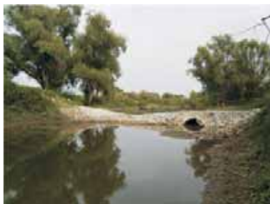
Abb. 8 und 9: Pilotprojekt „Altwasser Pillmoos“: Einbau eines Stahlrohrdurchlasses (Höhe 1,70 m, Breite 2,6 m) und teilweise Absenkung der Überfahrt
