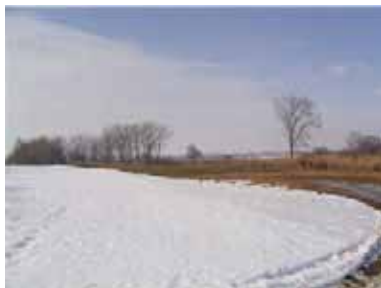
Abb. 2 und 3: Querriegel am Schöpfwerkskanal Öbling (Straubing): Vor der Rodung und nach der Rodung
