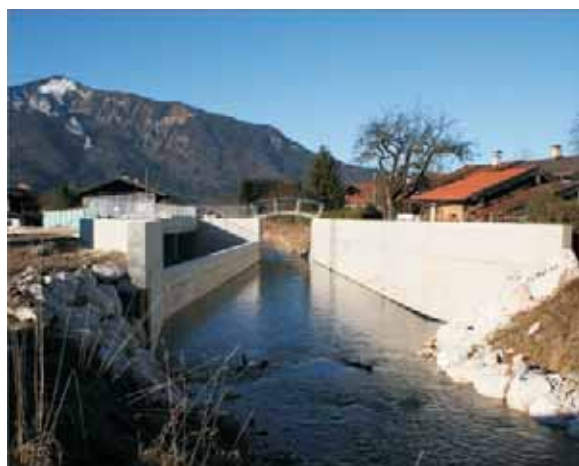
Abb. 4: Entlastungsbauwerk mit Streichwehr
