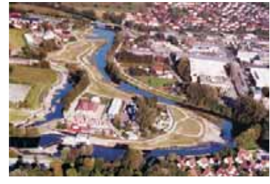
Rottschleife nach Fertigstellung der Bauarbeiten / vor Bepflanzung
