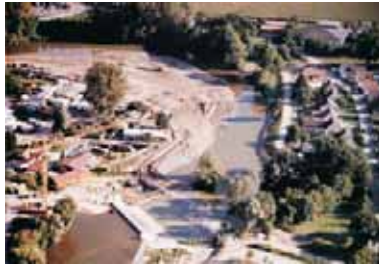
Rottschleife während Bau
