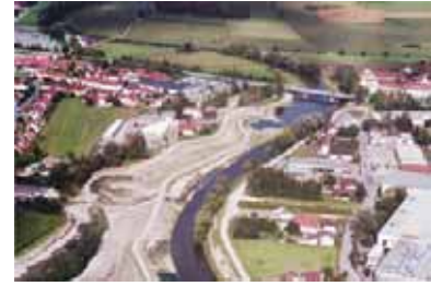
Blick Richtung St2112 nach Fertigstellung der Bauarbeiten / vor Bepflanz.
